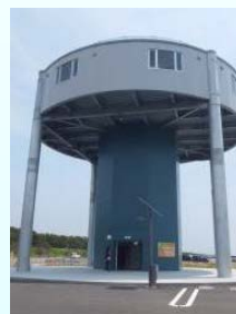
津波避難タワー
