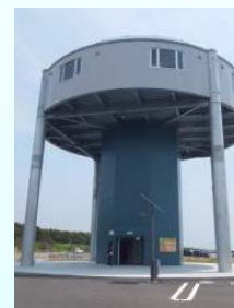
津波避難タワー
