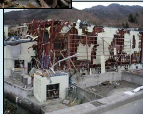
水産物冷蔵施設
