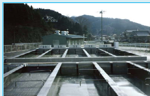
さけ・ます種苗生産施設
