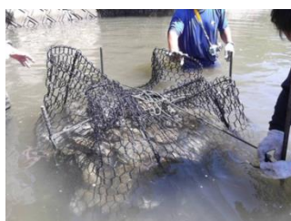
石倉などによる水生生物の生息環境改善
