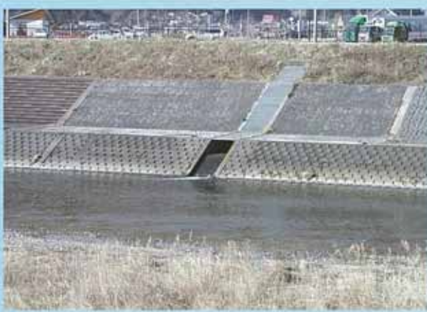
コンクリートで固められた川岸
