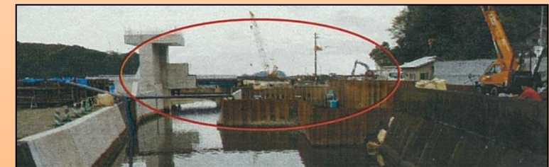
津波に対応した水門整備(津波浸水防護ライン)
