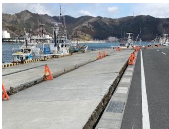
（岸壁 沈下）
