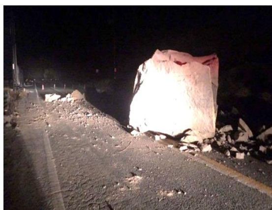
（臨港道路 道路沿いの崖の崩落）
