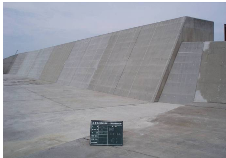
西防波堤19災3号 復旧状況
