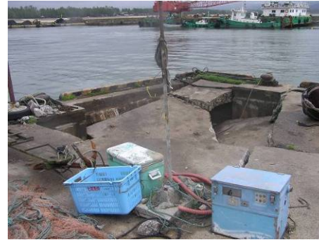
岸壁の沈下
