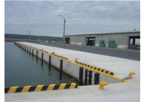
岸壁 復旧状況
