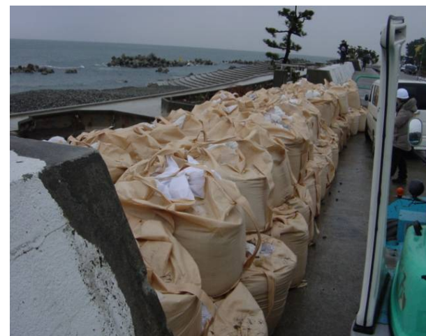
りっこう 陸閘の応急工事(入善漁港海岸)
