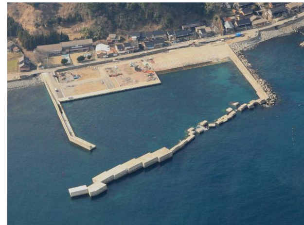
防波堤の滑動・転倒(北小浦漁港)
