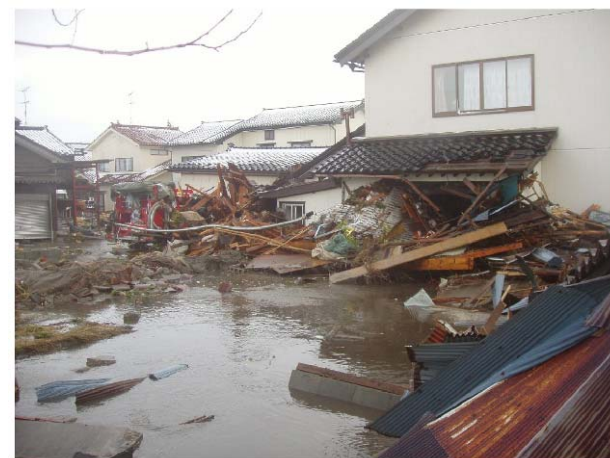
背後集落の被害(入善漁港海岸)
