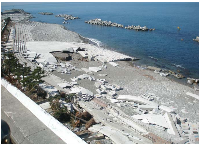
護岸の被覆ブロックの飛散(入善漁港海岸)
