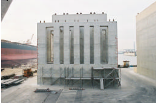
防波堤の整備
