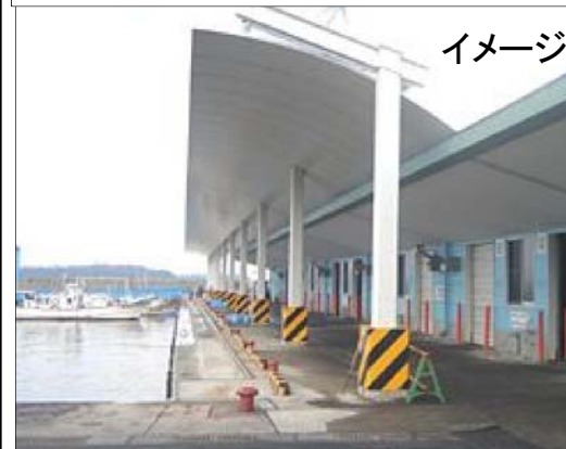
庇設置（防暑・防塵・防雨対策）
