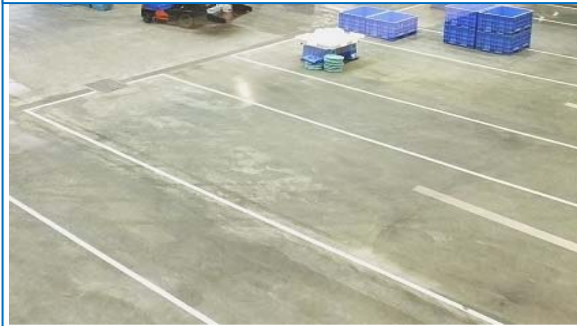
当初計画 (コンクリート打ちっぱなし床面)
