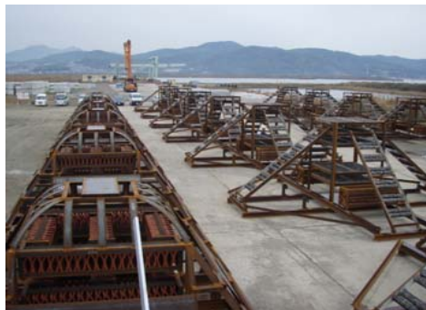
増殖場の施工状況
