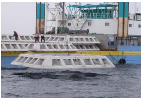
魚礁の施工状況
