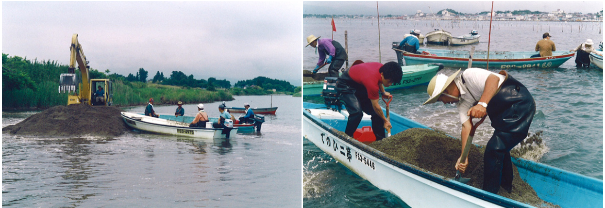
図 4.4.1 人力によって行なわれている客土作業
