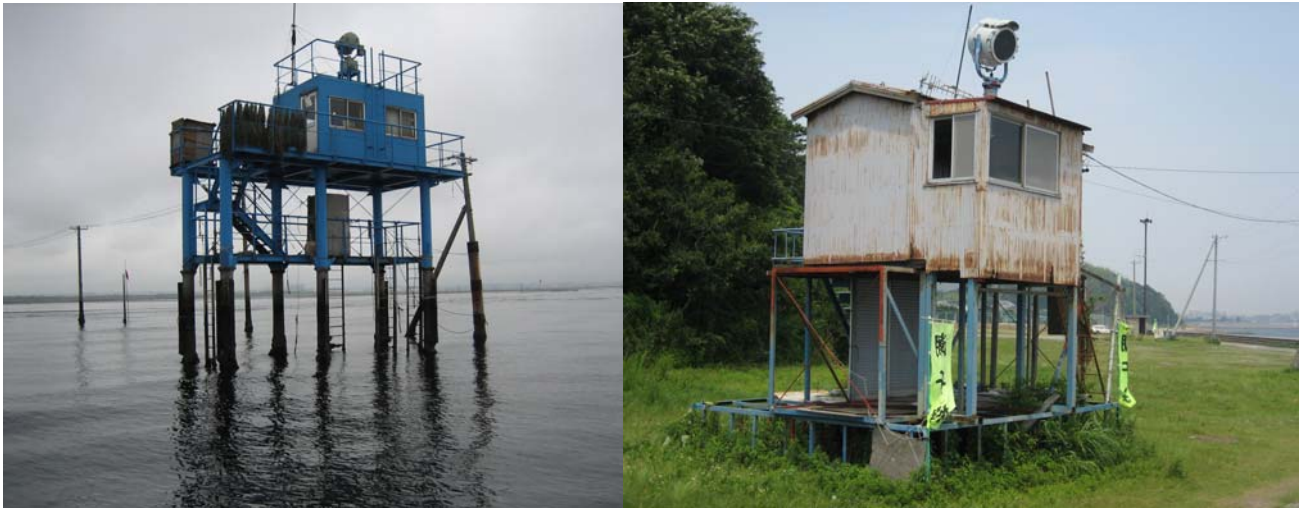
図 4.3.3 金田地区（左）と東幡豆地区（右）の漁場監視のための施設
