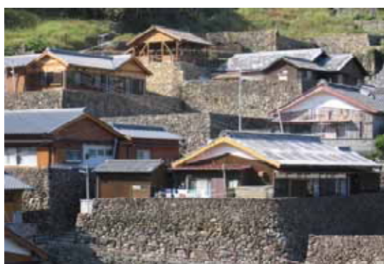
冬季の強い北西風から漁村の家屋を守るため明治初期に建造された石垣(愛媛県愛南町)。
