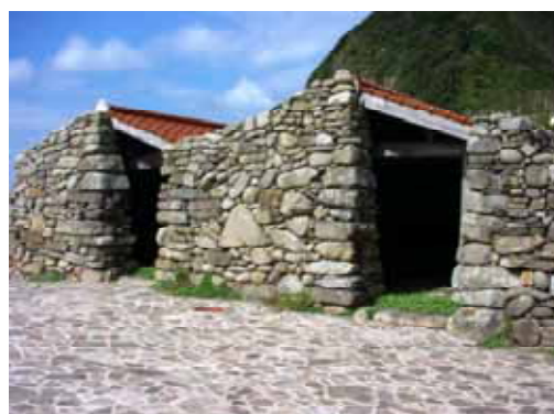
船泊りがない荒磯に浜石を積み上げ屋根を葺いて造られた舟屋(藻小屋)(長崎県対馬市)。
