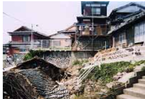
地震により被災した玄海島の集落
