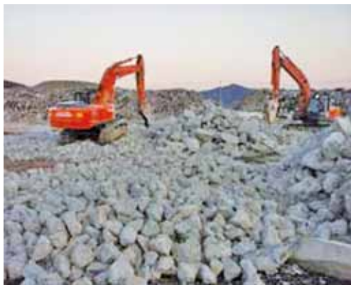
図1. 被災した防波堤の解体状況
