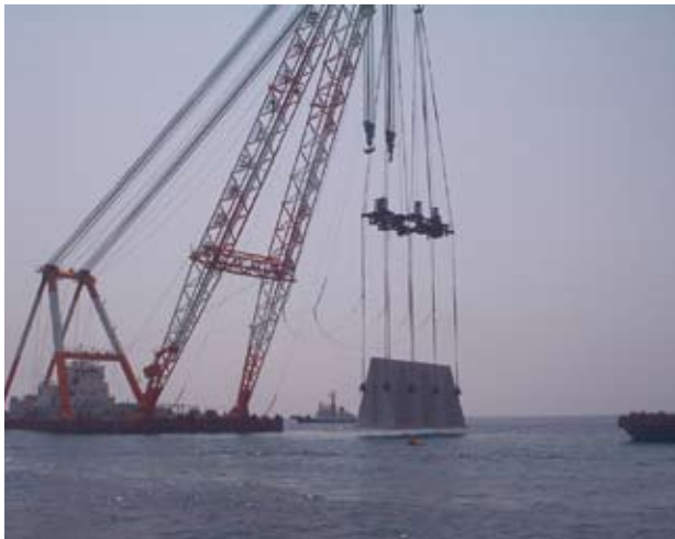
図-2 衝立型湧昇流発生構造物
