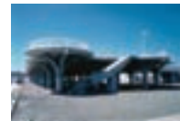
漁港施設用地(人工地盤)※漁港施設
