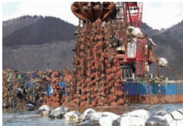
写真 被災した養殖施設の撤去作業 提供：岩手県庁
