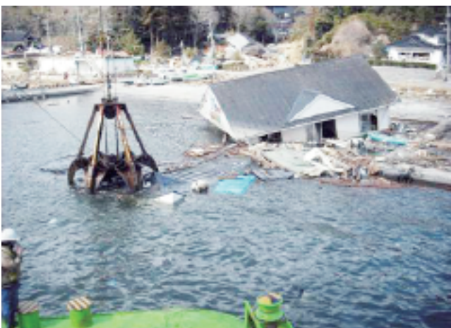
水路の障害物撤去（石巻漁港）
