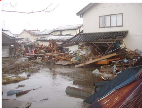
建物・家屋の損壊
