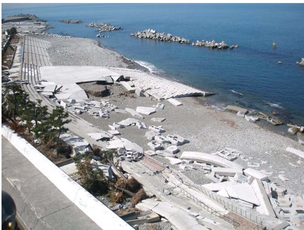
写真Ⅱ-2-5 海岸保全施設の被災状況
