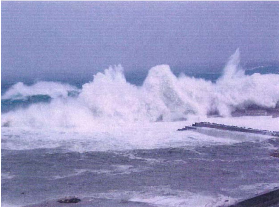
写真Ⅱ－2－6 鷺崎漁港の高波の状況
