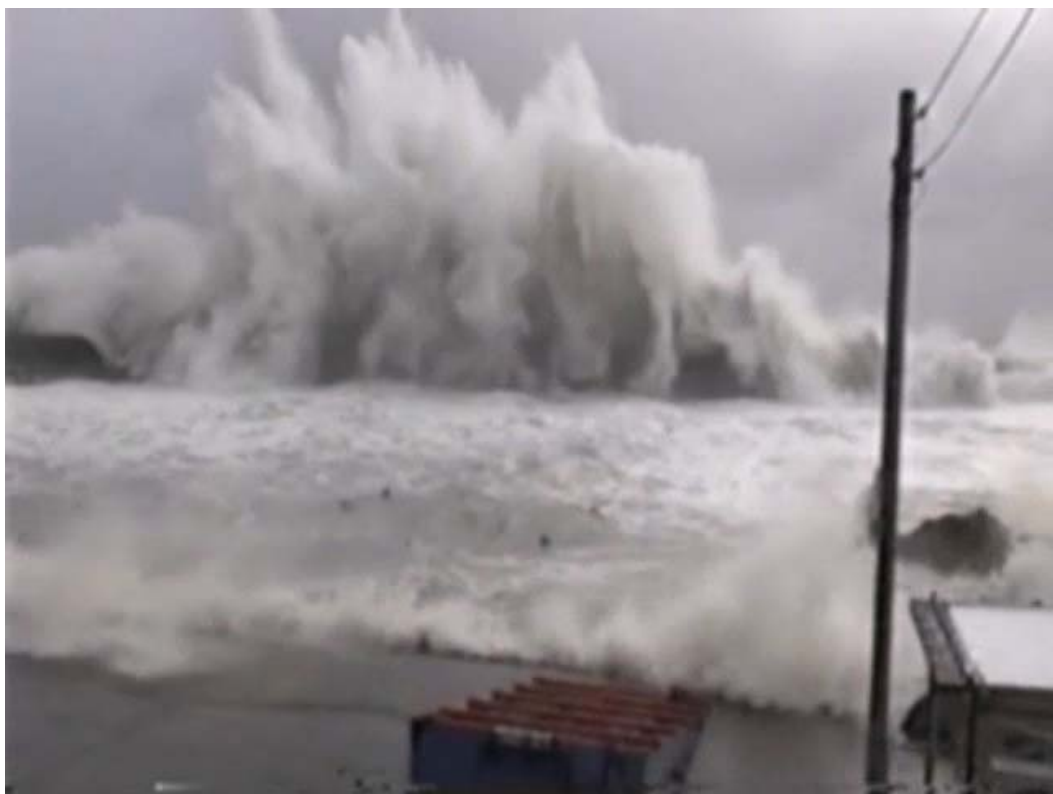
写真Ⅱ－2－7 北小浦漁港の高波の状況
