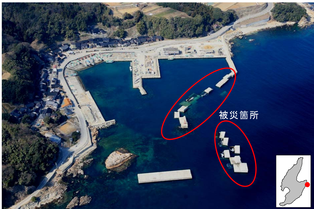
写真Ⅱ－2－11 水津漁港の防波堤の被災状況
