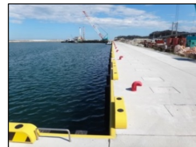
岸壁の耐震強化
