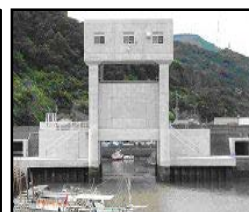
津波・高潮対策としての水門整備
