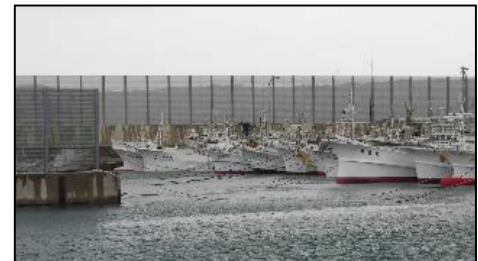
防風施設の設置により港内の静穏を確保
