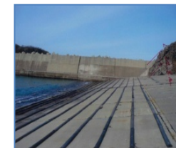
物揚場等の係留施設
