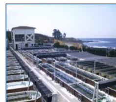
魚類・貝類 種苗生産施設
