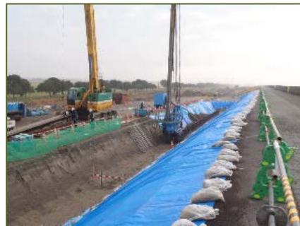
鋼矢板打設による耐震対策
