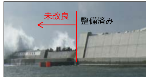
防波堤の高上げによって越波を防ぎ、港内の静穏を確保
