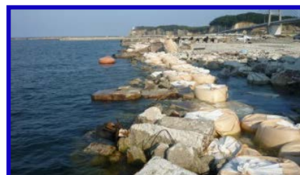
地震・津波に対応した岸壁の改良
