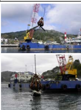
漁港内のがれき等の撤去
