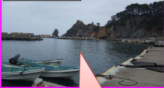
航路・泊地のがれきを撤去
