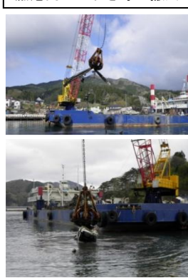
漁港内のがれき等の撤去
