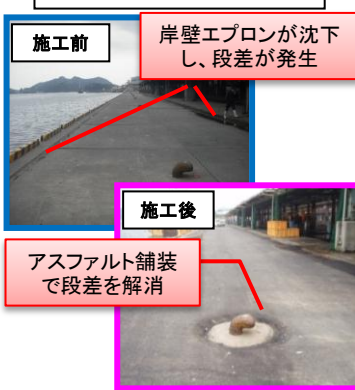
岸壁エプロンの段差すりつけ
