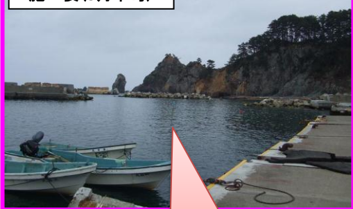
施工後(5月中旬)
