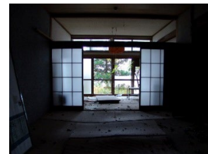
老朽化したホテル・旅館の改修
