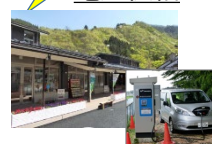
EV車等への給電設備
