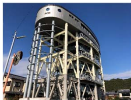
津波避難タワー
