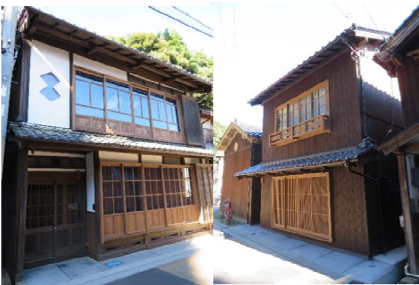
舟屋を改修した宿泊施設
