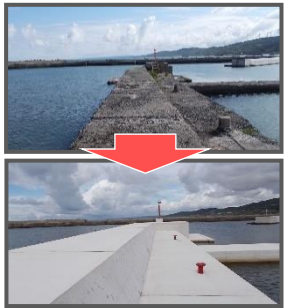
漁港施設の長寿命化対策
