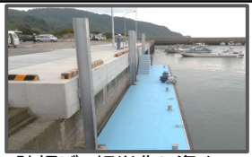
陸揚げの軽劣化に資する 浮体式係船岸の整備
