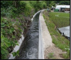
老朽化した用水路の整備・更新
