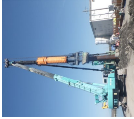
耐震対策（鋼管杭による施工）
