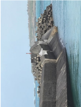
防波堤の損傷 (令和 8 年台風 9 号)
