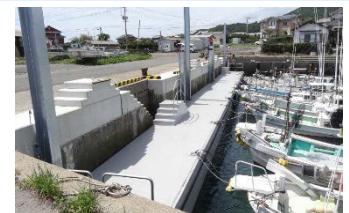
浮体式係船岸の整備による作業の軽労化
