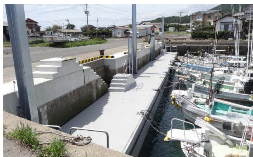
漁港のバリアフリー化 (浮き桟橋の整備)
