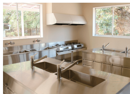
図工室を調理場に改修
