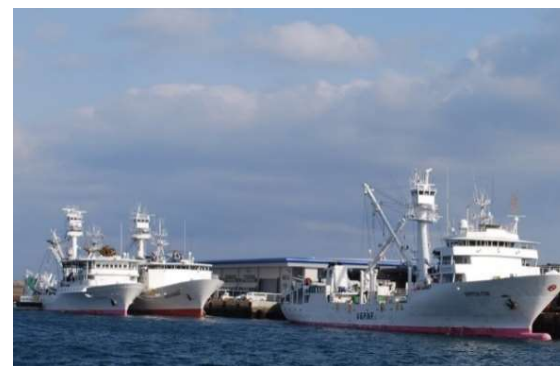
大型漁船に対応した岸壁
