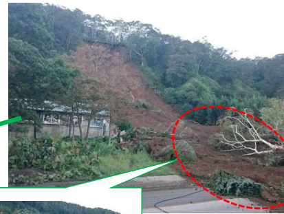
大雨による土砂崩れで道道通行止。町内6地区が孤立。 (平成28年8月24日～30日)
