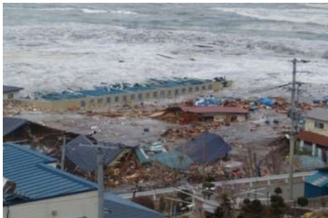
津波の来襲状況
