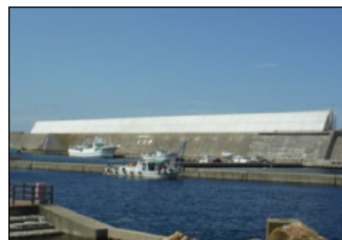
防波堤の嵩上げによる越波防止
