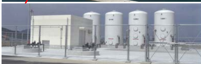
井戸より採水した海水をろ過・殺菌する清浄海水導入施設
