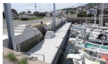
浮体式係船岸の整備による作業の軽労化
