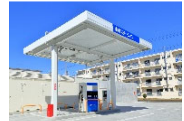
漁船のための燃料供給施設
