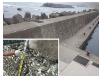
コンクリートの劣化・欠損
