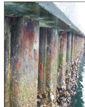
矢板の腐食により 岸壁が老朽化
