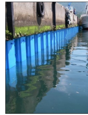
被覆工法により矢板の腐食を抑制し、岸壁の耐用年数を延長
