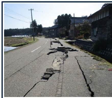
地震動（液状化）による 管渠のたわみ・損傷
