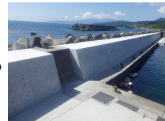
コンクリートを補修し、防波堤の耐用年数を延長
