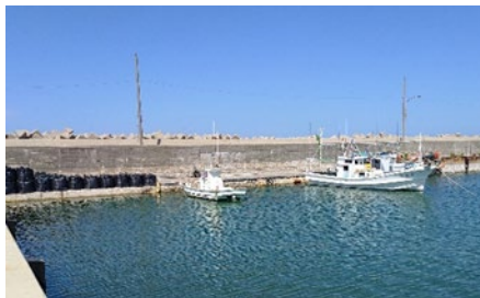
狼煙漁港での岸壁切り下げによる仮復旧（珠洲市 R7年4月）
