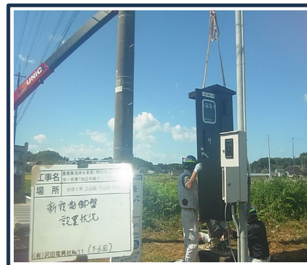
管路中継ポンプの制御版の更新
