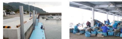
漁港における就労環境改善対策の実施(浮体式係船岸、屋根施設等)
