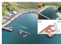
防波堤の倒壊
