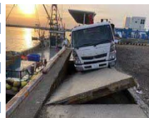
護岸エプロンが陥没
