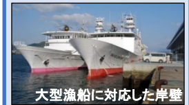
大型漁船に対応した岸壁
