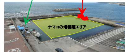
ホタテ漁等の中型漁船の利用を同漁港の別地区に集約し、海水交換施設を整備し、泊地をナマコの増養殖場として活用。
