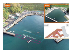
防波堤の倒壊
