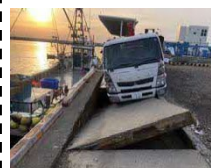
護岸エプロンが陥没
