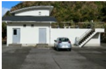
漁業集落排水施設
