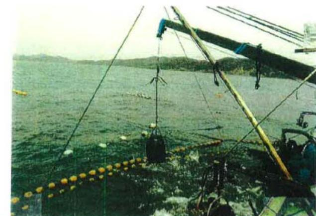
① ステンレスイカリにサンドバッグ500kgを取り付けクレーンで魚捕部へ。
