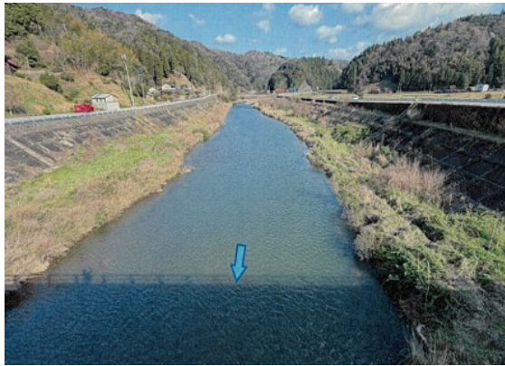
水路化した河川
