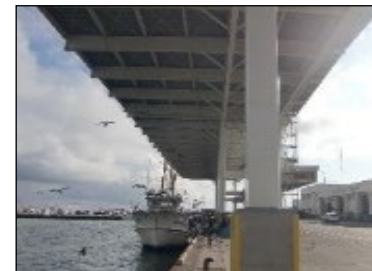
岸壁屋根の整備
