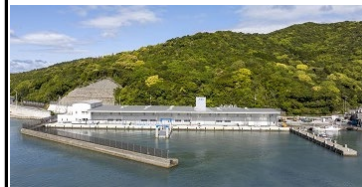
完成した荷さばき施設
