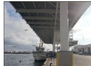
岸壁屋根の整備
