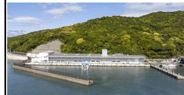
完成した荷さばき施設
