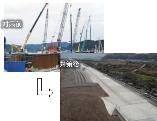
海岸堤防の耐震対策
