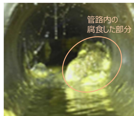
排水施設の強化 (腐食した管路の更新、耐震性強化)
