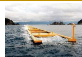
漁港周辺の水域における養殖施設（消波施設）の整備等により養殖漁場を形成
