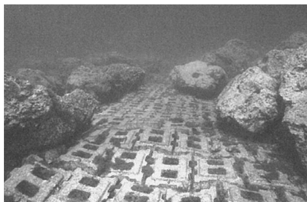
フレキシブルコンクリートマットで被覆
