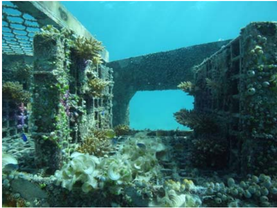
写真 4.20 格子状基盤を使った浮泥の堆積を軽減した例
