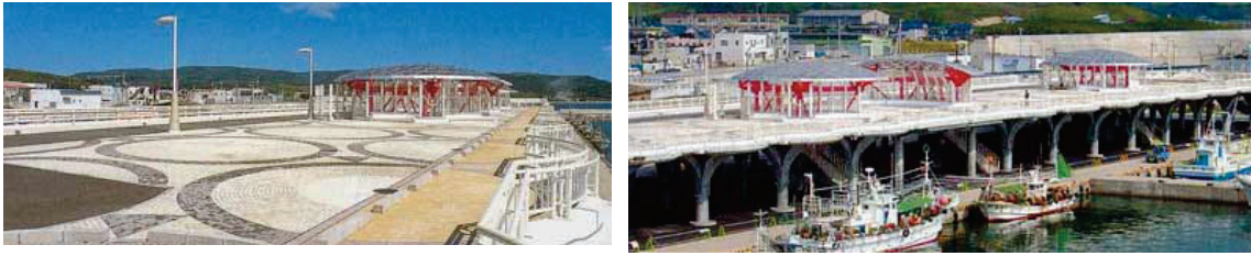
青苗漁港人工地盤
