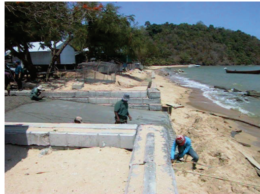
建設中の漁村の護岸と斜路
