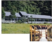
(体験施設として改修した旧校舎)
