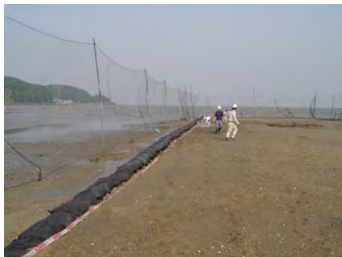
図 5-4-3 土嚢設置（日本水産資源保護協会より）
