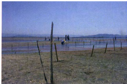
(被覆網の設置作業)
