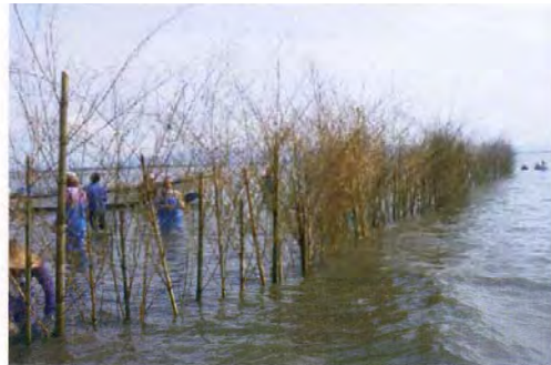
(竹シバの設置作業)
