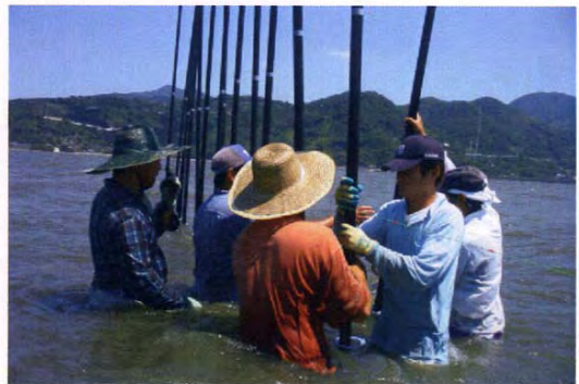
(漁場整備における淡水防護策設置)
