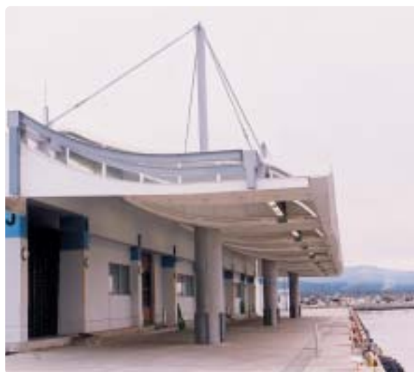
異物混入防止、温度管理のための屋根付き岸壁の整備
